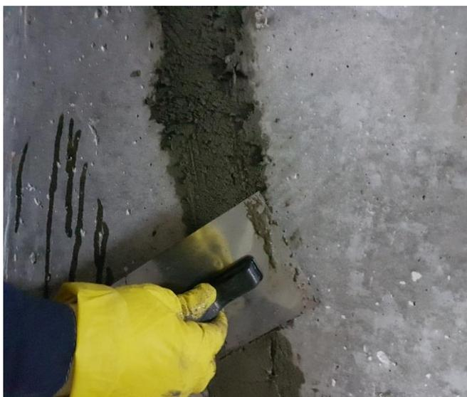
**Назначение.** Смесь используется для конструкционного ремонта потолочных, наклонных и вертикальных поверхностей с глубиной повреждений (сколов, выбоин и др.) до 60 мм. Выдерживает действие агрессивных сред, имеющих водородный показатель pH не менее 5,5.
