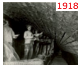
Между 1918 и 1922 годами в 67 тоннелях была сделана гидроизоляция с использованием добавки Sika®-1.
